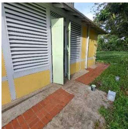
Travaux maison de Roura – PNRG 2023
